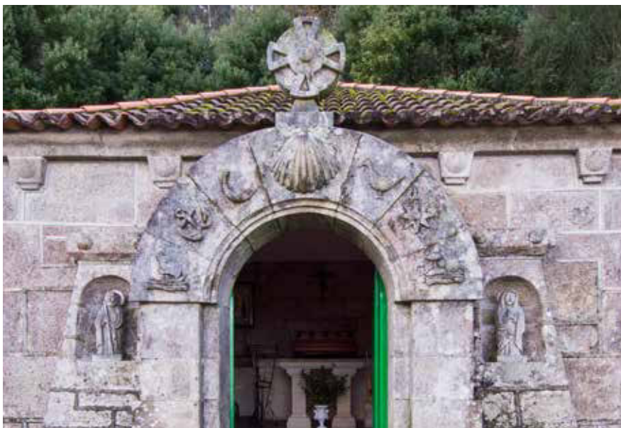
48. Detalle del pórtico exterior. Foto: Vicom.
